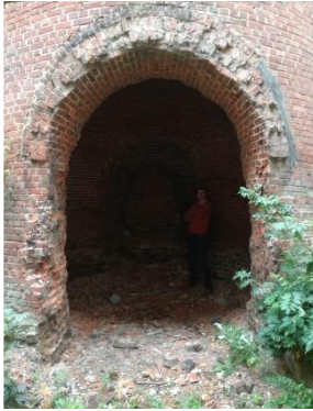
Figuur 47: de Sofinal schoorsteen
