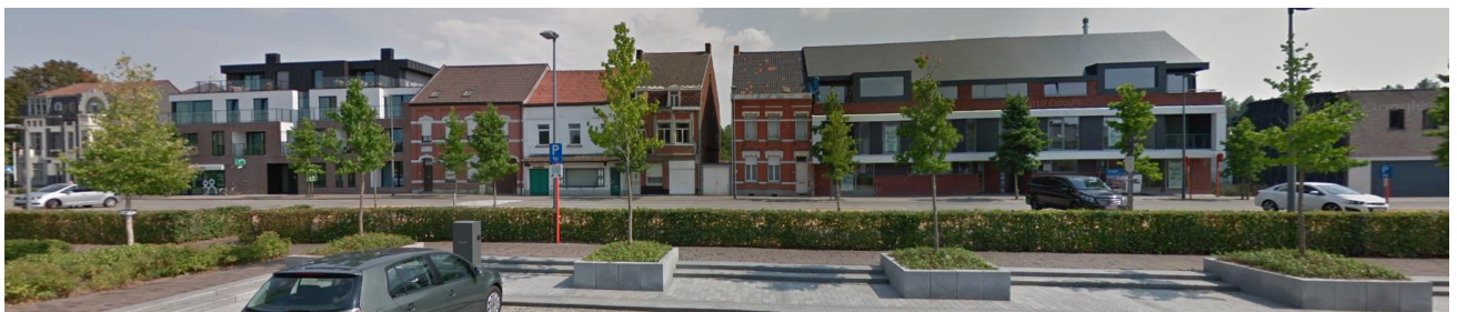
Figuur 50: bebouwing in de Parklaan
