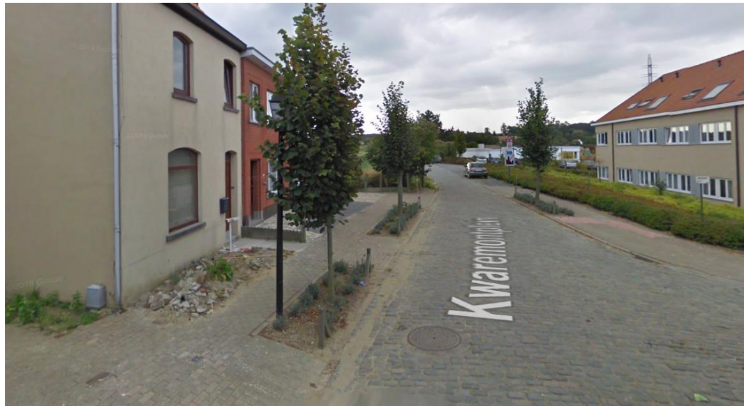
Figuur 35: Locatie Kwaremontplein waar bronmaatregelen op openbaar domein genomen kunnen worden (bron: Google Streetview).
