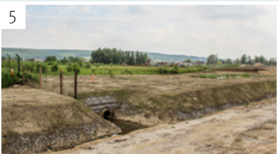
zicht vanaf de nieuwe ontsluitingsweg richting de Molenstraat
