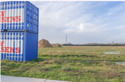
Vorbereidende werken bouw metaalverwerkend bedrijf Vergalle
