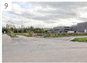
zicht op de nieuwe gebouwen van bucomat en de oude toegangsweg naar de vroegere elektriciteitscentrale
