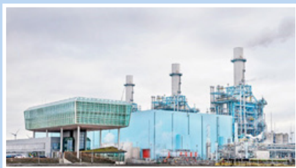
Gascentrale wordt superbatterij - opslag van elektriciteit in ammoniak © https://bouwenuitvoering.nl/vernieuwing/gascentrale-wordt-superbatterij
