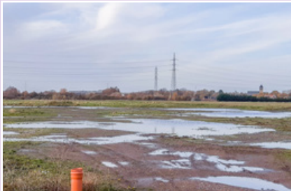
Bouwrijp maken van een perceel
