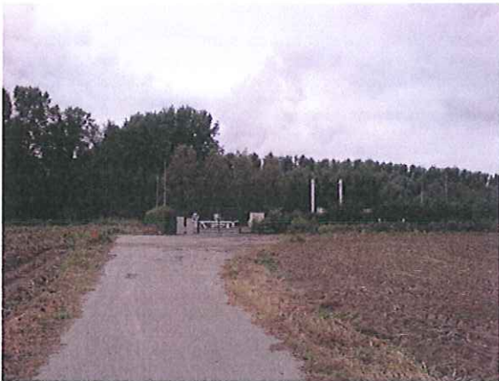
zicht op de gasinstallatie van fluxys
