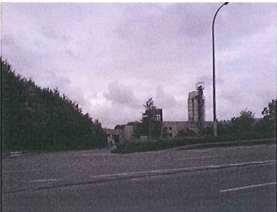
zicht op het bedrijf EWI NV, ter hoogte van dit bedrijf zal de nieuwe aansluiting op de N 8 dienen te komen
